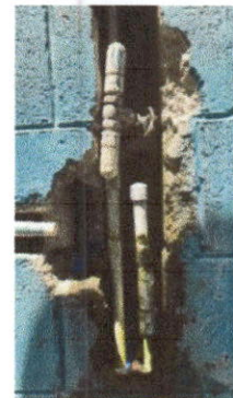
Foto 4: Sustitución de tubería línea principal
