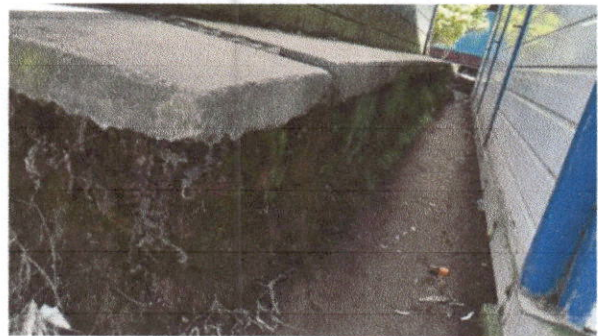
Foto 10: Reparación de banquetas de concreto
