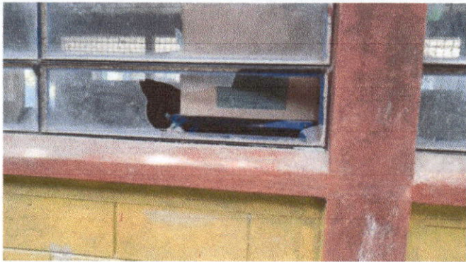
Foto 7: Sustitución de vidrios
