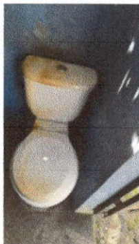
Foto 3: Sustitución de inodoro
