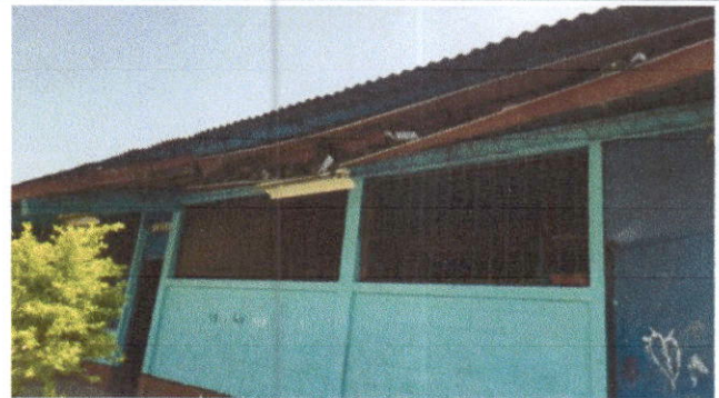
Foto 8: Sustitución de canal de metal
